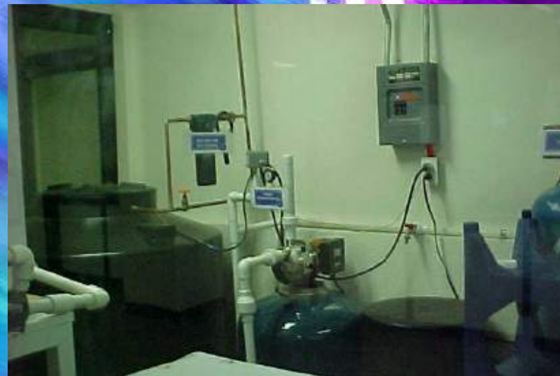
El 21 de noviembre de 2005 se terminó la instalación de la planta purificadora de agua del plantel. Proyecto del Ing. Eduardo Estrada
